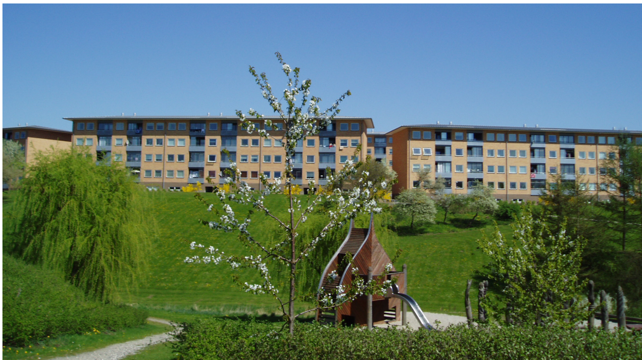
Figur 6.4: Billedet viser en af de nyligt renoverede afdelinger i Sundparken, Horsens, set fra Rytterkilledalen i vest.
